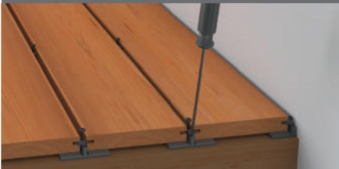
Drehen des Exzenters. Exzenter kann auf beide Seiten gedreht werden.
