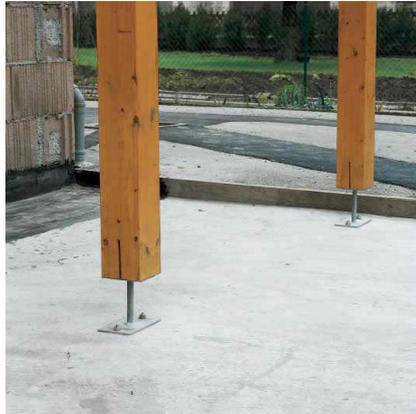
**Stabdübel mit Fase werden zur Verbindung von Stahlteilen in eingeschlitzten Holzquerschnitten wie beispielsweise Pfostenträger mit Schwert oder Holz-Holz Verbindungen verwendet.**
